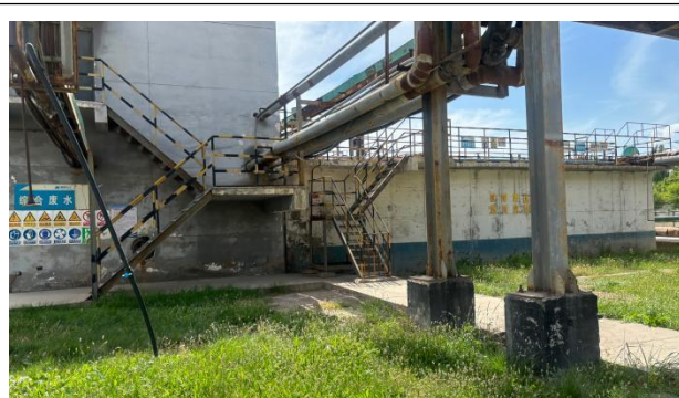
厂区综合污水处理站
