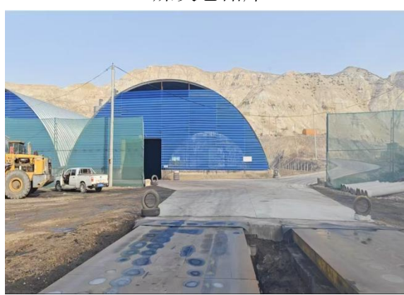
煤炭仓储库四周防尘网
