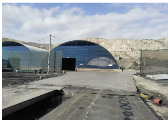
厂区地面硬化
