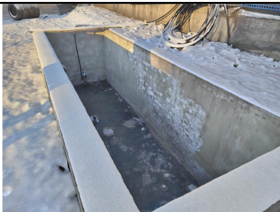
煤炭仓储库四周排水沟连接的沉淀池
