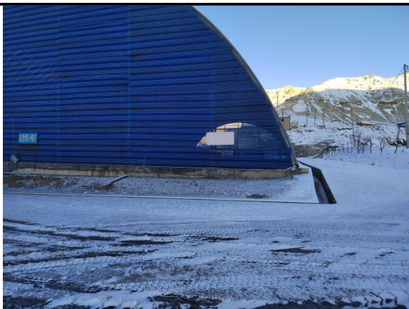
煤炭仓储库四周排水沟
