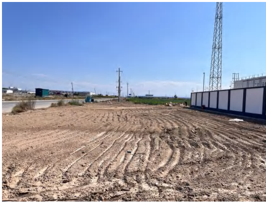
施工生产区恢复情况
