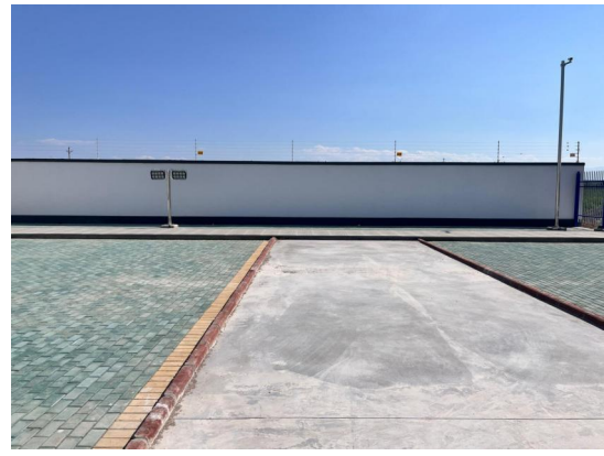
站内铺设地砖
