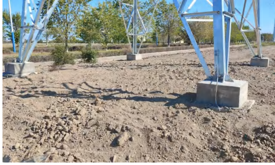
塔基恢复原地貌
