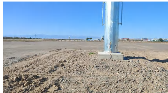
塔基恢复原地貌
