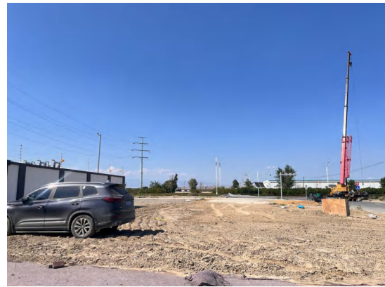
施工生产区恢复情况
