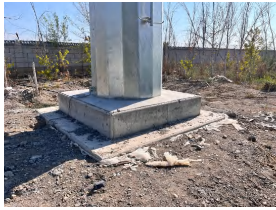
塔基恢复原地貌
