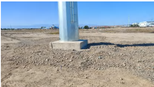
塔基恢复原地貌
