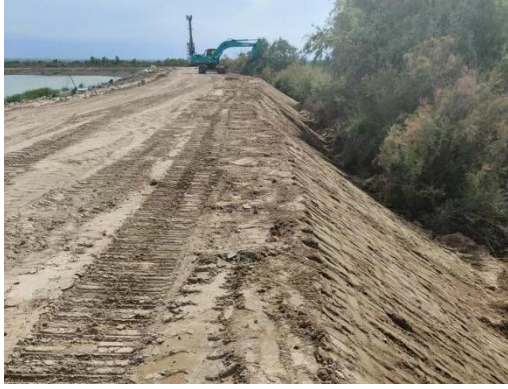
施工期弃方坝脚摊铺
