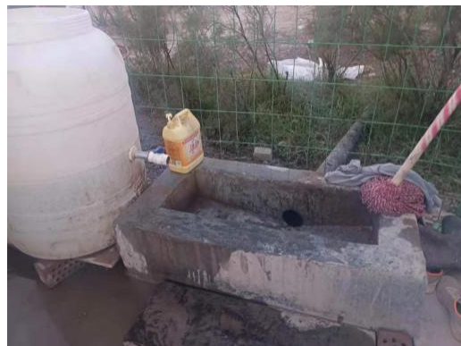
施工区排污池
