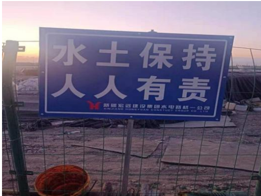
施工区警示牌
