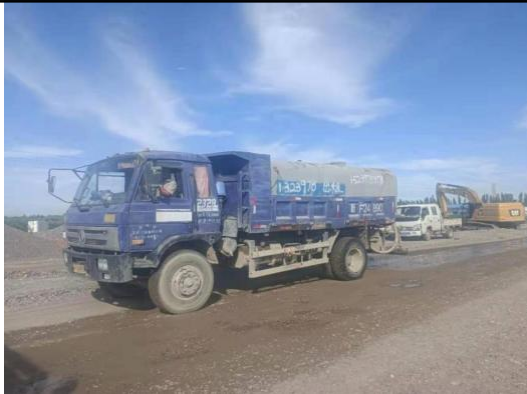
道路洒水降尘
