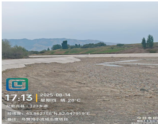
项目区左、右岸斜坡式现浇混凝土板
