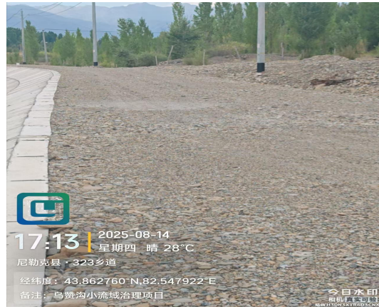
施工便道作为永久巡堤路
