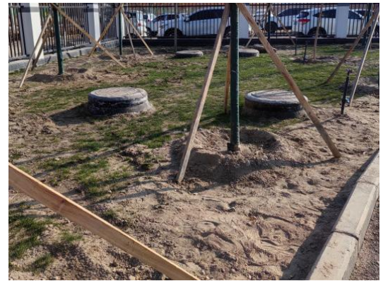
化粪池位置（地下）
