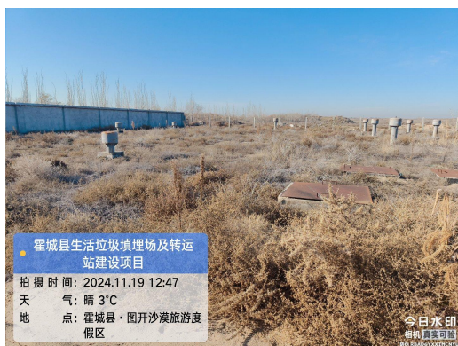
渗滤液水池全景
