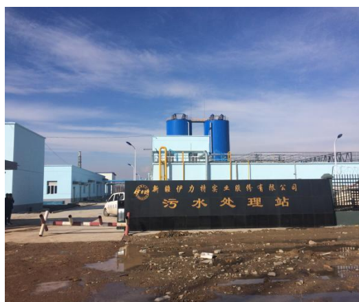
污水处理站全景
