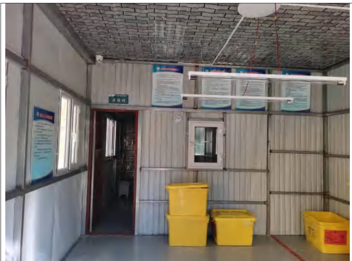
医疗固废暂存间内部
