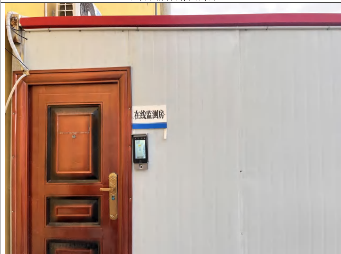
污水处理站在线监测房
