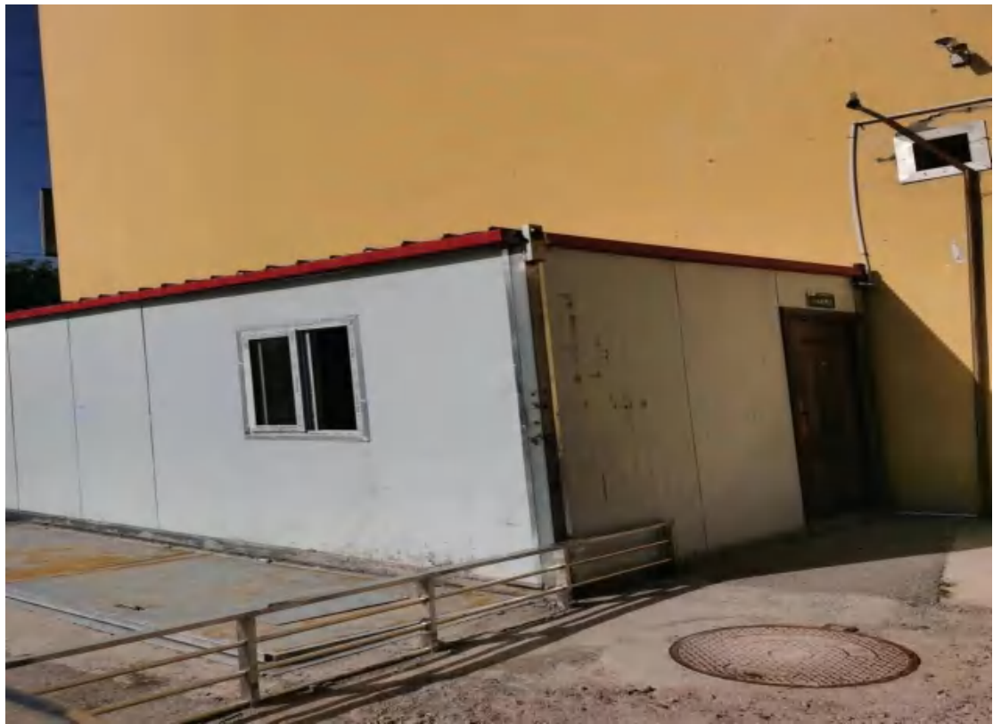
污水处理设备间
